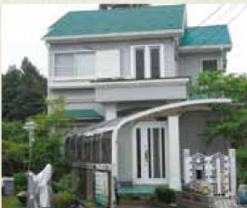
<外壁・屋根塗装>
