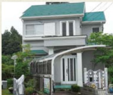
<外壁・屋根塗装> Lクラス
